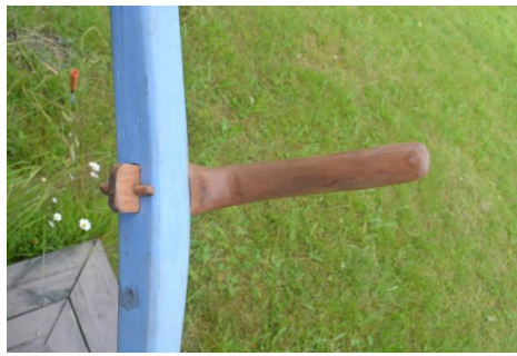
Bild 8 Knagge monterad med längre tapp och kil
