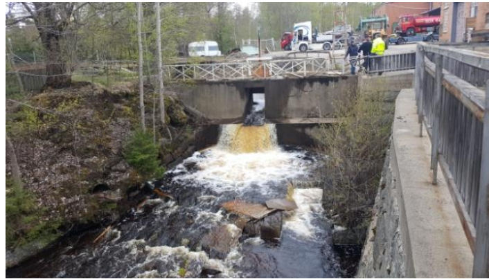
Ovan: Den gamla dammkonstruktionen T.h. Frigörande fritt fall när dammen rivs ut
