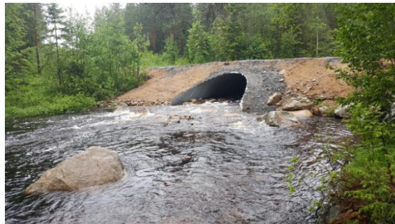
Den nya vandringsvänliga vägtrumman
